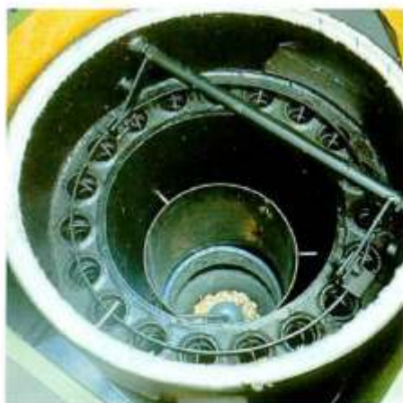
Sorgt für eine gute Wärmeübertragung: Wärmetauscher mit Turbulatoren
